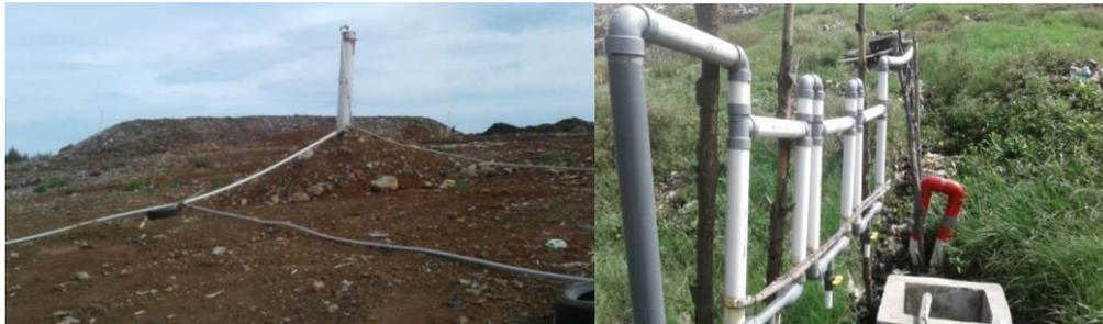
Gambar 1. Pipa vertikal dan Pipa Pengumpul Lindi
