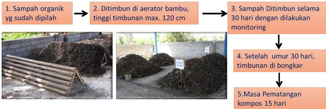
**Gambar 16. Alur kerja pengolahan aerator bambu**
